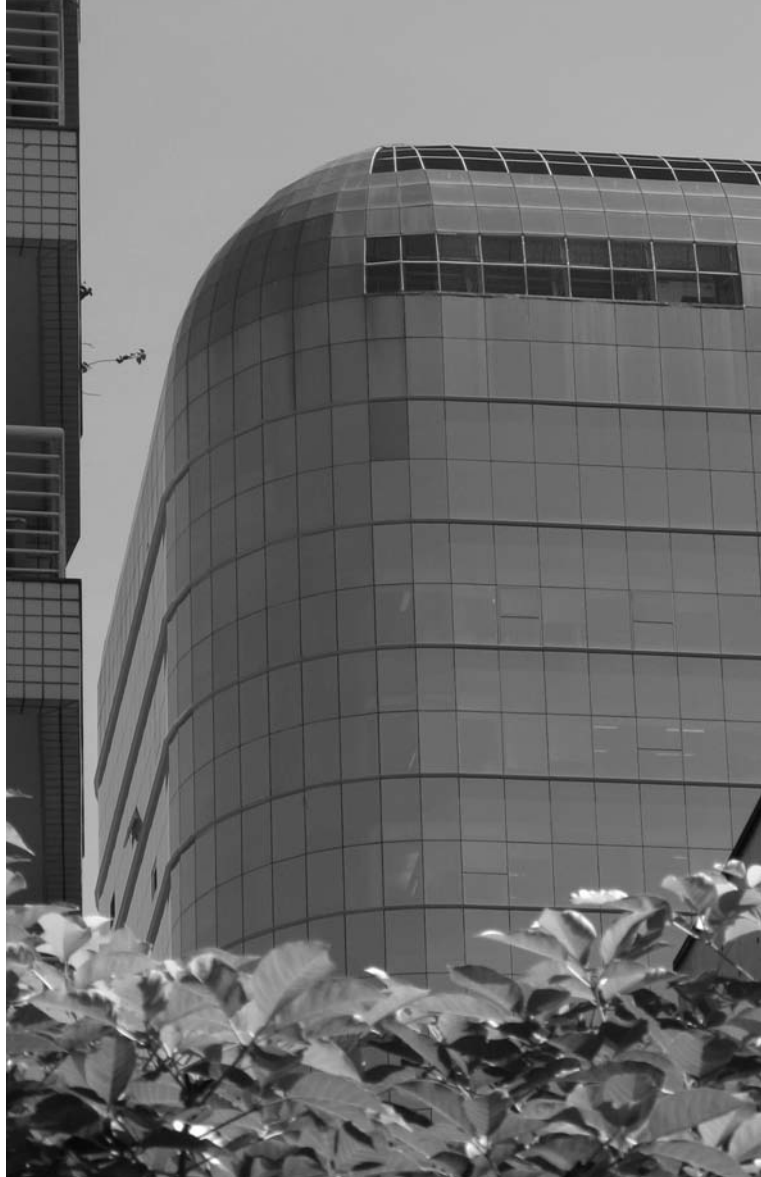
Ruy Ohtake, Edifício Berrini 500, São Paulo, 2008, detail.
