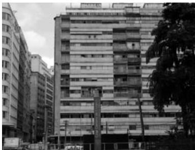
Álvaro Vital Brazil, Edifício Esther, São Paulo, 1934–6.
